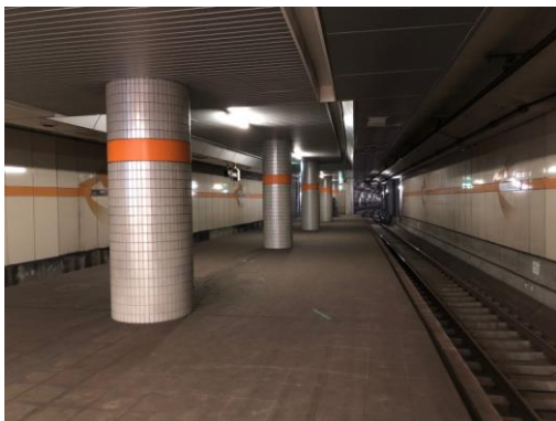
（工事前）東川口駅の8両編成列車対応ホーム部分
