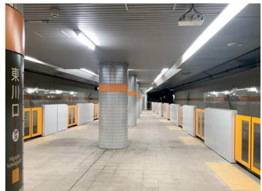
（工事後）東川口駅の8両編成列車対応ホーム部分
