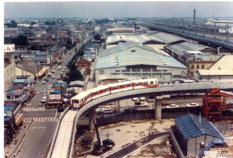
大宮駅を発車してループ線を走行する （JACKビル建設中）
