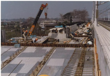
小針駅（仮称・現内宿駅）建設風景
