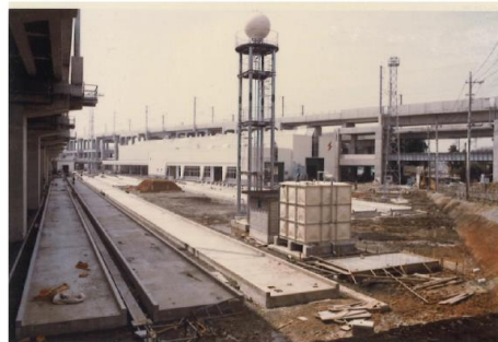
留置線建設風景
